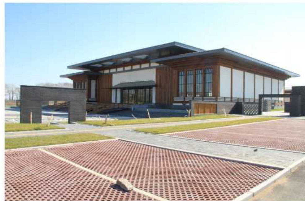
渤海响水小镇新区服务中心
