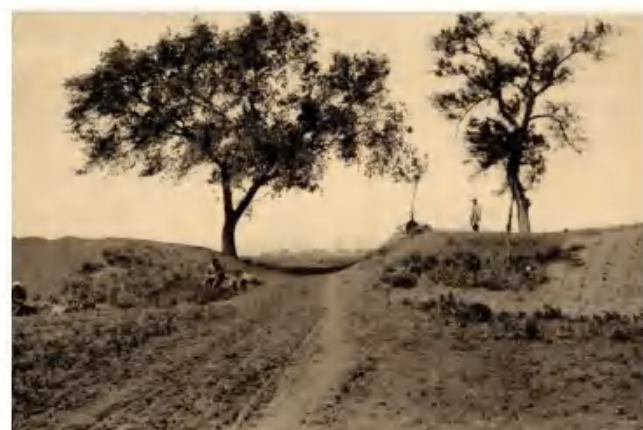
外城东壁缺口
